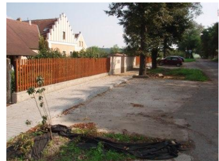
Oprava parkoviště a chodníku před Domovem sv. Anežky
