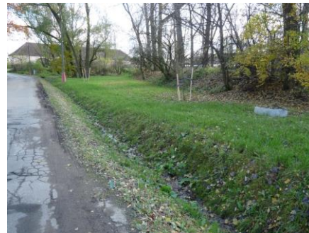
Zavezení a srovnání nerovností naproti gymnáziu (projekt „Terénní úpravy před buší“)
