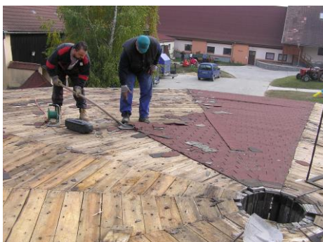
oprava střechy jízďárny
