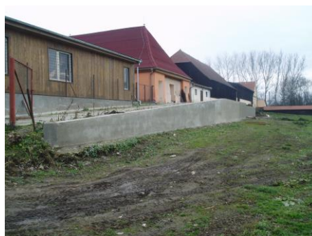
oprava betonové rampy u konířny
