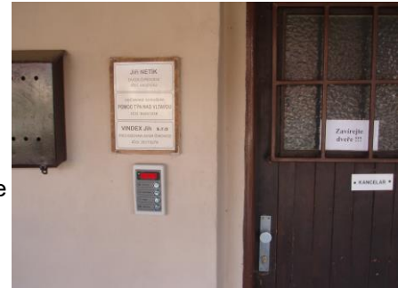
Pořízení a instalace zabezpečovacího a docházkového systému
