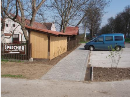
Oprava parkoviště a chodníku před Špejcharem a výsadba zeleně
