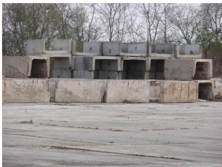
Pořízení betonových U-profilů na zabezpečení hnojiště
