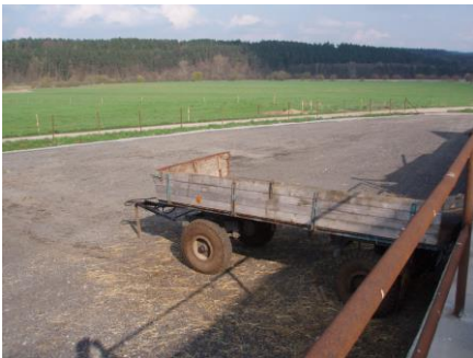
Oprava a zpevnění odstavné plochy pod konírnou
